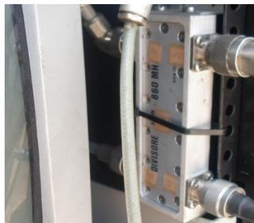
**Fig. 3: Híbrida de 4 puertos 470-860 MHz**
