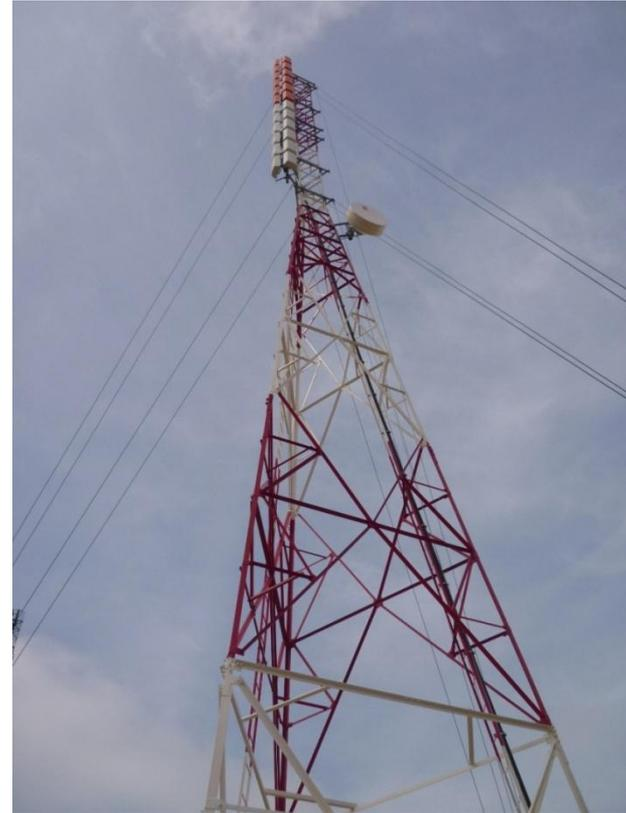
**40mts** de altura, 12 Paneles a **0° N** , 12 Paneles a **100°N**, Polarización: **Horizontal**
